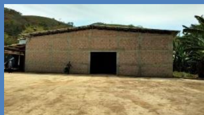
Galpões p/ armazenamento
